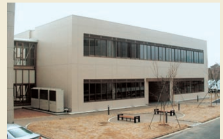
インキュベーション施設
