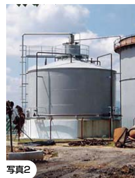
FELDA社Serting Hilir 工場に設置した500m 3 のメタン発酵タンク
