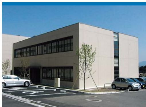
インキュベーション施設
